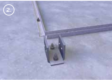
U-profielen bevestigen op betonplateau
