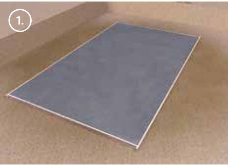
Betonplateau 15 cm gieten met wapeningsnet 8/8/150/150
