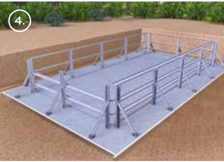
Plaatsing van de panelen (vastklikken + revetteren)
